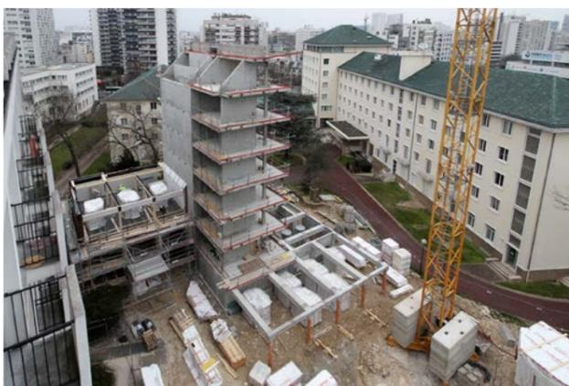
Le cœur en béton terminé, le montage de la structure bois démarre avec la partie l'Ouest du projet.
